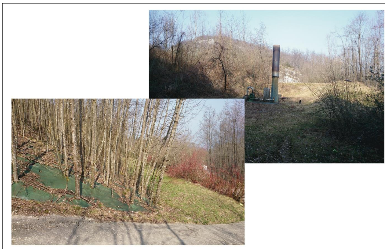
Figure 8 : Photographies pour illustrer l'état actuel de la décharge de l'Araignée.
